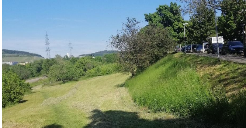
Foto 1: Böschung der Stauferstraße im Übergang zum nördlich abfallenden Gelände zur K 1858
