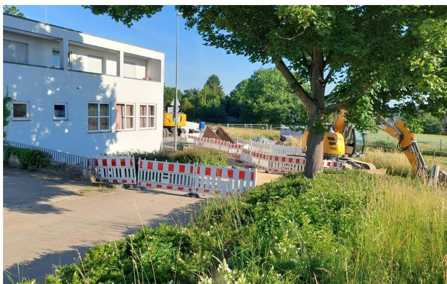
Baustelle an Kreuzung Kappellesweg / Geschwister- Scholl-Straße (Blick von Südosten, 17.06.2021)
